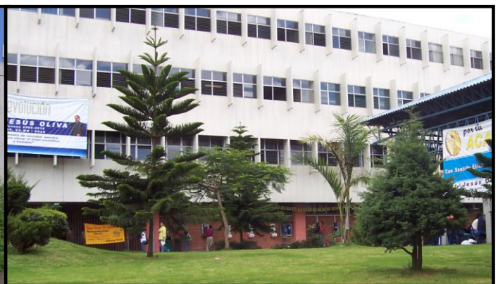
Edificio Centro Universitario Metropolitano -CUM-
